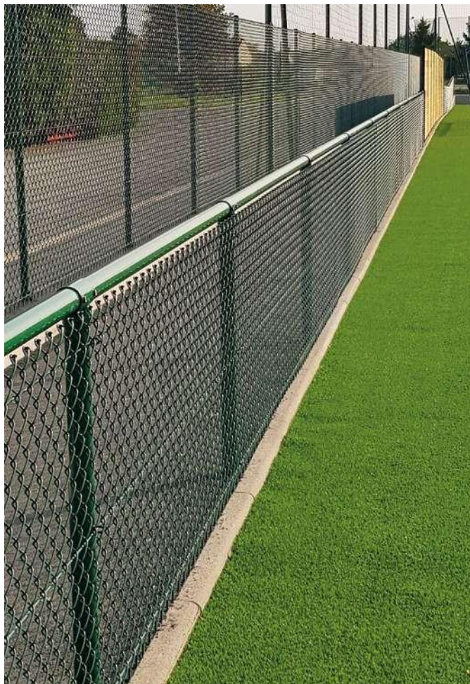
Remplissage simple torsion et adaptation au changement d'inclinaison du terrain
